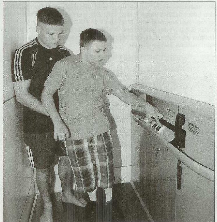
Mit den neuen Innenlift im Wohnhaus kann Jannik nun alle Räume im Haus erreichen, im Bild steht im sein Bruder Manuel noch hilfreich zur Seite. Foto: Fredi Brabänder.
