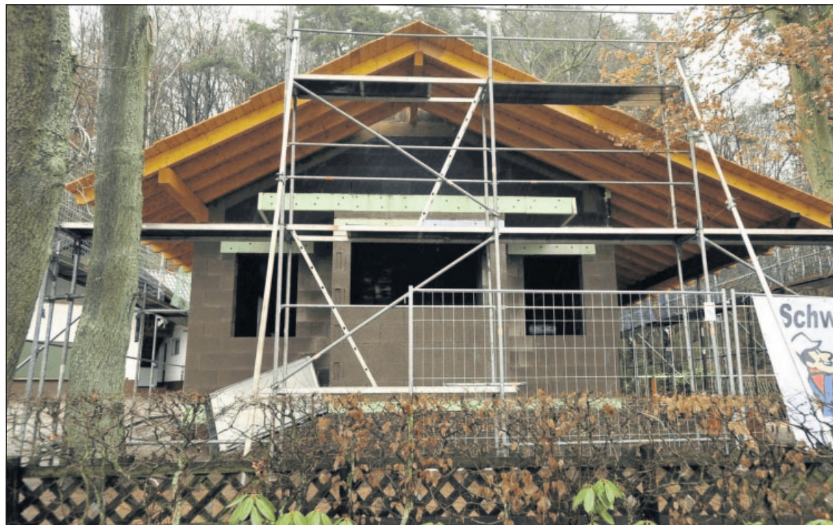
Erstaunlich weit fortgeschritten ist der Komplett-Neubau der niedergebrannten Wanderhütte. FOTO: MOSCHEL
